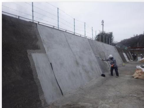
上塗工は、中塗工によって補修された面を保護する目的でLCトップコートを塗布する。
