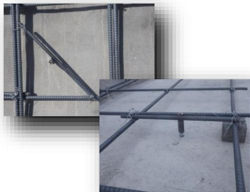
LCラクールは、高さ調整を行い、**正確なかぶり厚**の確保する。
