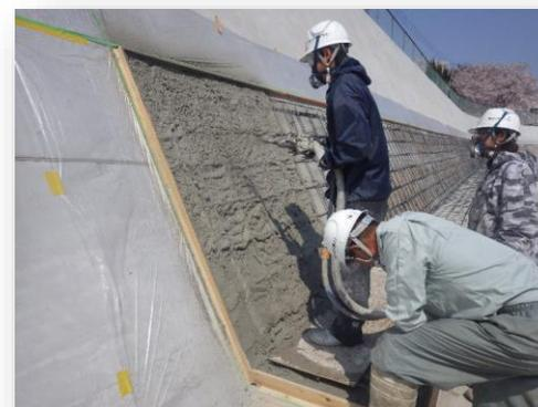
下塗り材プライマーの塗布後ポリマーセメントモルタル（LCモルタル）を（ $t=6.0\text{mm}+$ 不陸）の厚さでコテ塗り（または吹付）を行い滑らかな面に整形する。
