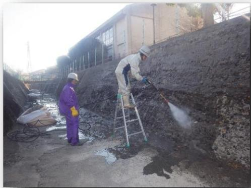
コンクリートの遊離石灰、塵埃、油分、レイトランス及び付着している苔、藻等を除去する。
