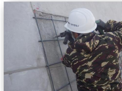
LCラクールを取付けるためにアンカーを打つ。
