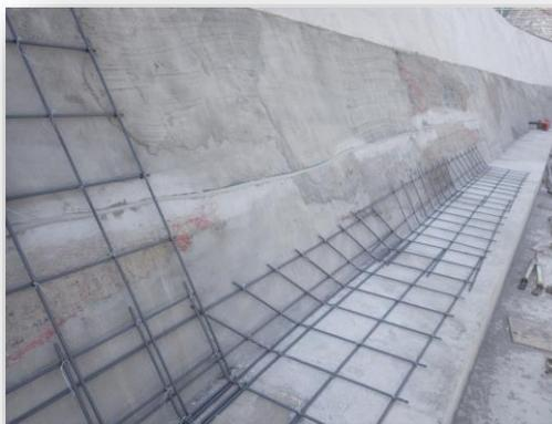
工場から折りたたんで輸送されたLCユニット鉄筋を広げ、下地に設置
